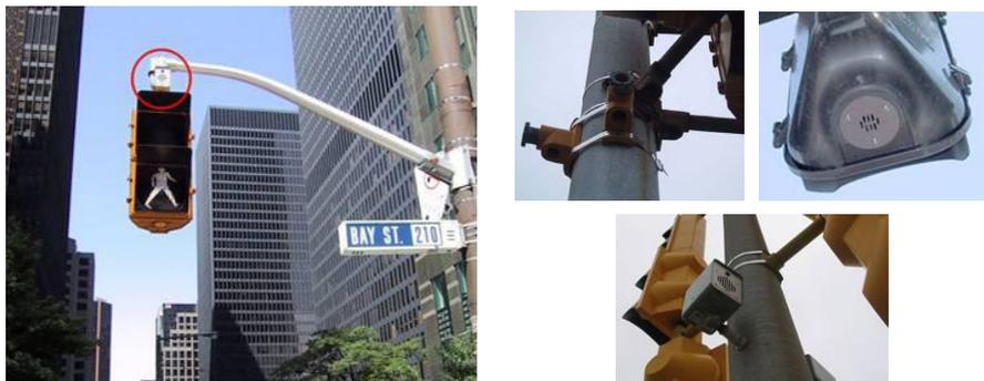
Рис. 89. Примеры размещения звуковых устройств сигнала и ориентации (рисунок в центре вверху), применяемых в США
