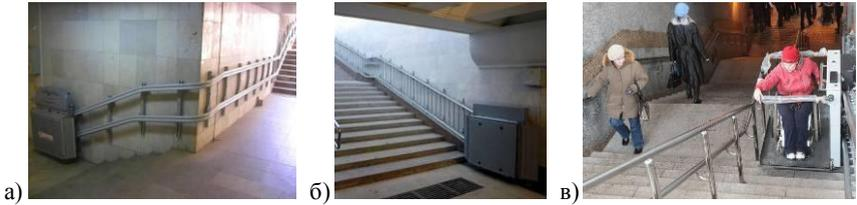
Рис. 118. Примеры внеуличных пешеходных переходов, оборудованных подъемниками для маломобильных групп населения
