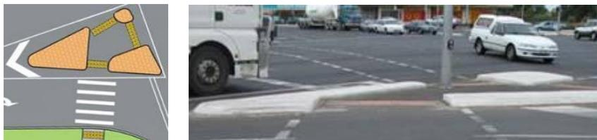
Рис. 83. Обустройство пешеходной части островков безопасности треугольной формы на одном уровне с проезжей частью
