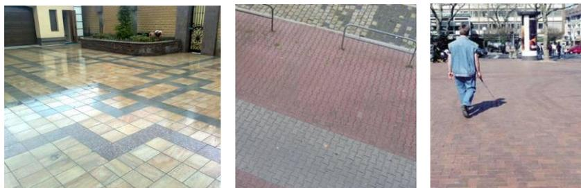
Рис. 28. Поверхности, не являющиеся тактильными наземными указателями
