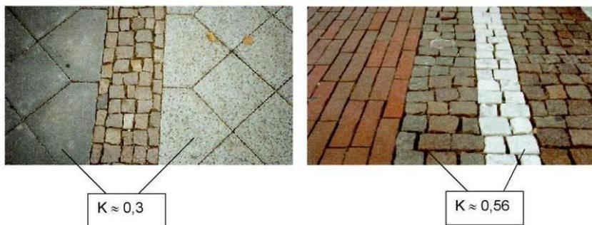
Рис. 39. Пример применения тактильных наземных указателей, имеющих различные значения яркостного контраста с поверхностью тротуара
