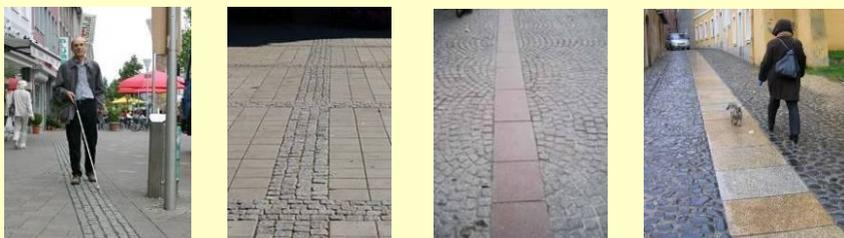
Рис. 24. Наземные тактильные направляющие устройства из булыжного камня и гранитной плитки (Германия, Норвегия)
