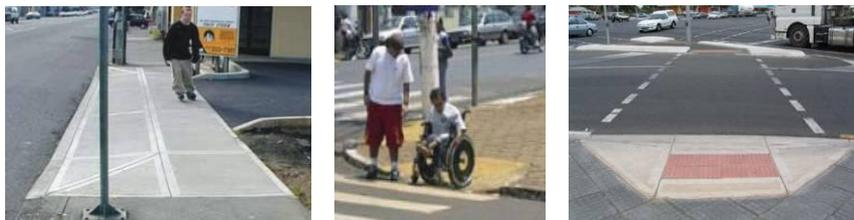
Рис. 69. Примеры обустройства пандусов со скошенными гранями (а – США, б – Бразилия, в – Австралия)
