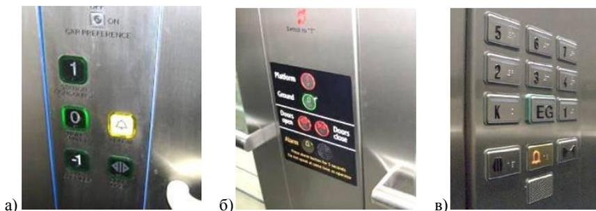
Рис. 126. Визуальное и тактильное выделение кнопок на панели управления лифтом
