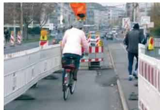
Рис. 51. Пример исполнения пандуса на временной пешеходной дорожке
