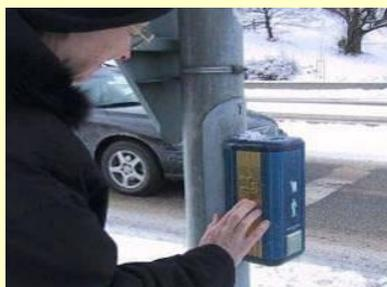
Рис. 99. Тактильный указатель на боковой грани вызывного устройства (Швеция)
