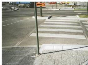
Рис. 54. Пример универсального обустройства пешеходного перехода (Финляндия)
