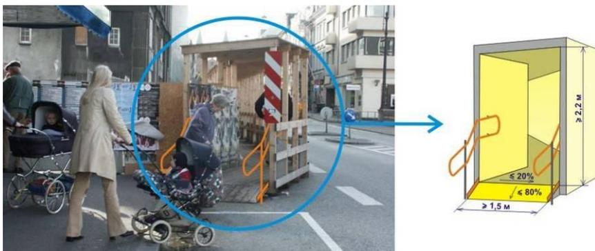
Рис. 53. Основные параметры коридора безопасности, выполненного на тротуаре или пешеходной дорожке в месте производства строительных работ
