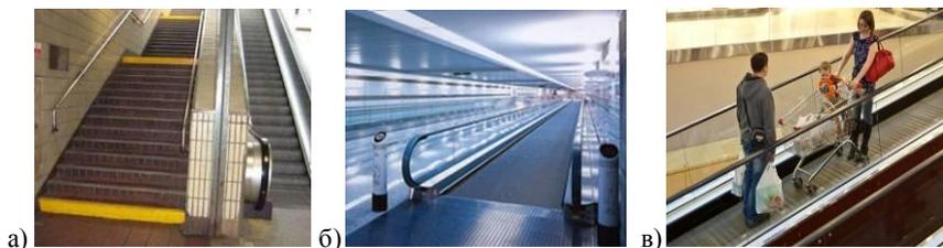
Рис. 96. Примеры эскалатора (а) и траволатора (б, в)
