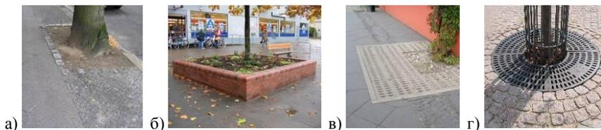
Рис. 49. Примеры обустройства объектов пешеходной инфраструктуры в местах произрастания зеленых насаждений
