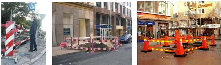
Рис. 52. Примеры ограждений в местах производства дорожных работ (Дания, Норвегия, Швеция)
