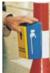
Рис. 92. Пример контрастного выделения вызывного устройства и опоры светофора
