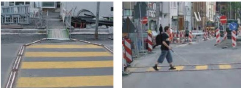
Рис. 142. Пример обустройства временного пешеходного перехода
