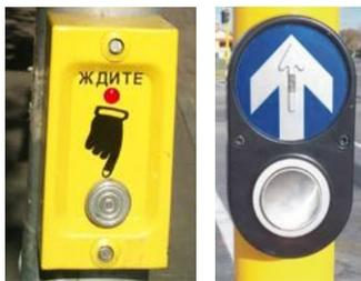
Рис. 93. Примеры контрастного выделения вызывной кнопки и корпуса вызывного устройства
