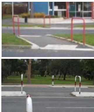
Рис. 85. Примеры размещения поручней на островках безопасности (Англия, Австралия)
