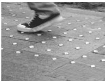
Рис. 31. Пример эластомерной тактильной поверхности
